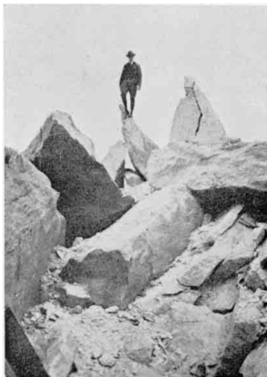
Havets evindelige Stormløb mod Bulbjergklinten forårsager Tid efter anden store Skred i det massive Limstensbjerg. (Johs. Christensen fot.).
