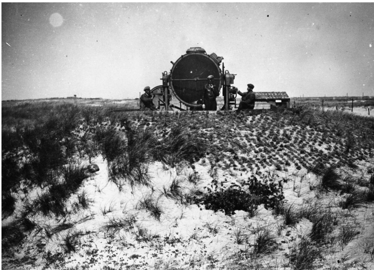
Lyskaster ved hofde i Agger.
