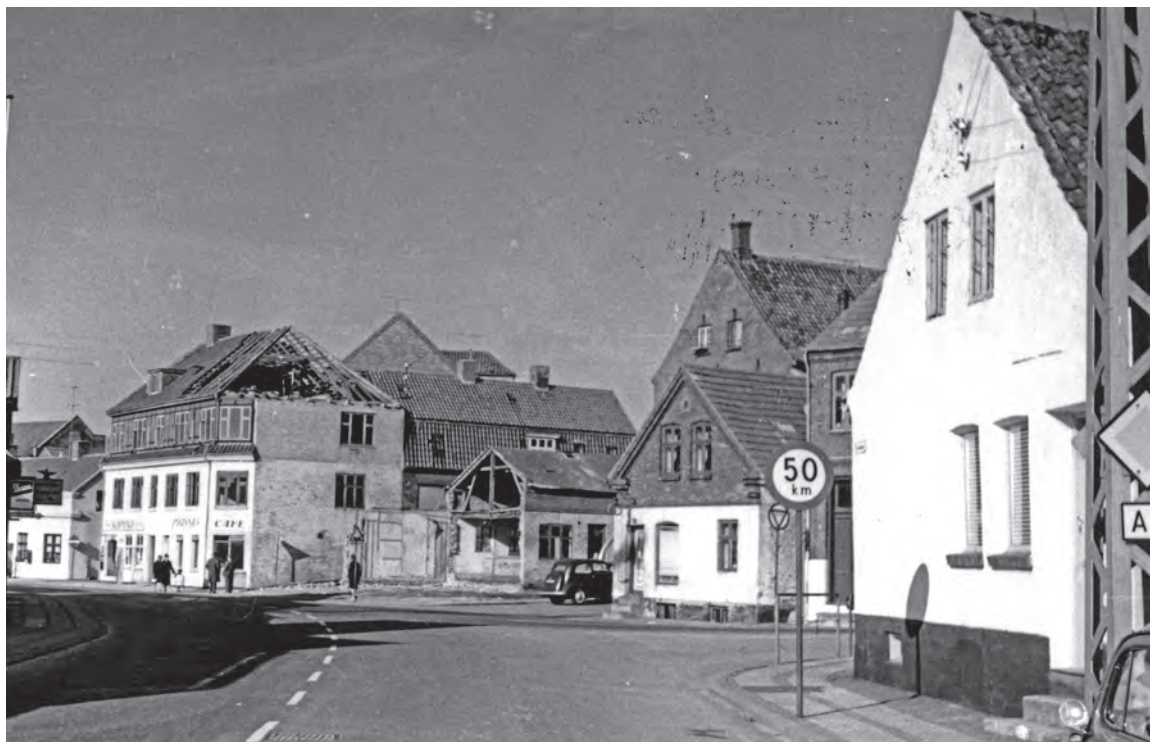
Et kig hen mod Strandgade 7 før nedrivningen i 1963. Hovedvejen går fortsat ud forbi slagteriet, og biler fra Østerbakken måtte standse op ved et skilt med »fuld stop«. Lokalhistorisk Arkiv for Thisted Kommune.
