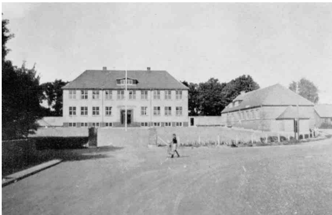
Fjerritslev Kommuneskole opførtes 1938-39 efter Tegninger af Arkitekt A. Krogfeldt, Fjerritslev. Den smukke og anselige Skole har 5 Klasseværelser, Skolekøkken etc. i Henhold til de nye Skolelove. Den kostede ca. 105.000 Kr.
