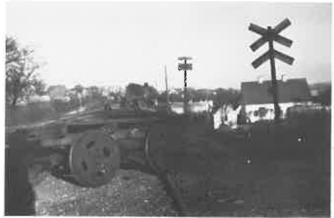
Reparation af banelinjen ved Torp efter sabotage.
