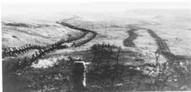
16 Tankspærringer – spanske ryttere – nord for Hanstholm.
