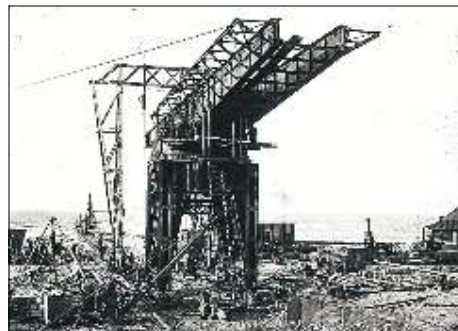
DEN STORE kran, der blev benyttet til molebyggeriet, blev stående helt frem til 1930, hvor den blev solgt som gammelt jern.
