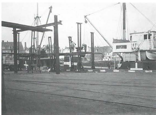
Stilladset for losning under opstilling. Den øverste del til venstre er på plads.
