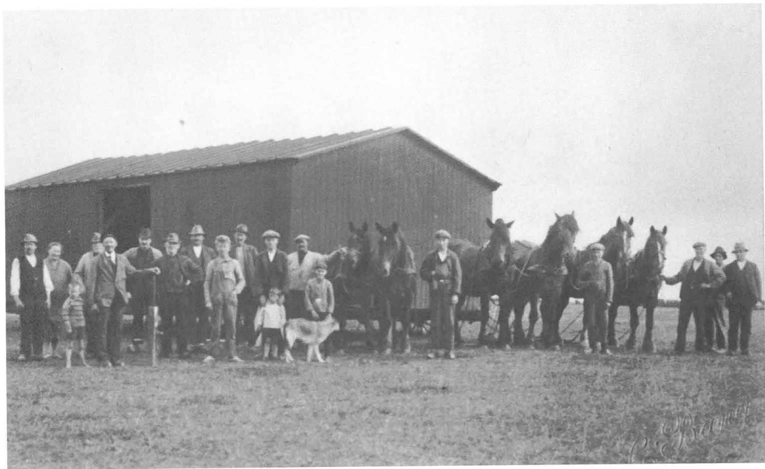
Ved Hørdum station havde købmand Møller i Koldby et pakhus, fortæller Egon Johansen, Legindvej 13, Hørdum. Da købmanden ikke længere havde brug for det, blev det solgt til Søren Bangsgaard, »Kristiansminde«, nu Legindvej nr. 8. Billedet er fra flytningen ca. 1930. Fra venstre Søren og Signe Bangsgaard, Signes far »gamle Sørensen«, foran ham vognmand Chr. Jensen med sønnen Erhardt, Hans Andersen »Vestergård«, Gamle Madsen (uddeler Preben Madsens farfar), vognmand Jensens søn Jens, tømrer Kr. Munkholm, tømrer Knudsen, to ukendte, tjenestedrengen med hunden er Reidar Petersen. Efter de to heste Klemmen Korsgaard, Gerhard Jensen med hesteforspand. De sidste tre ukendte. Et af hesteforspandene er fra vognmand Krogh.
