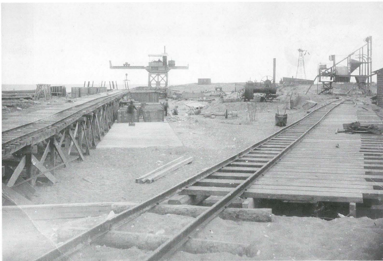
I Hanstholm opførtes i 1904 ud for Roshage en 310 meter lang mole ud til 5 meters vanddybde. Jørgen Hundahl, Tilsted, er i besiddelse af dette billede fra opførelsen af molen. En lokomobil drev cementblandemaskinen, og en vindrose sørgede for at pumpe vandet op.
