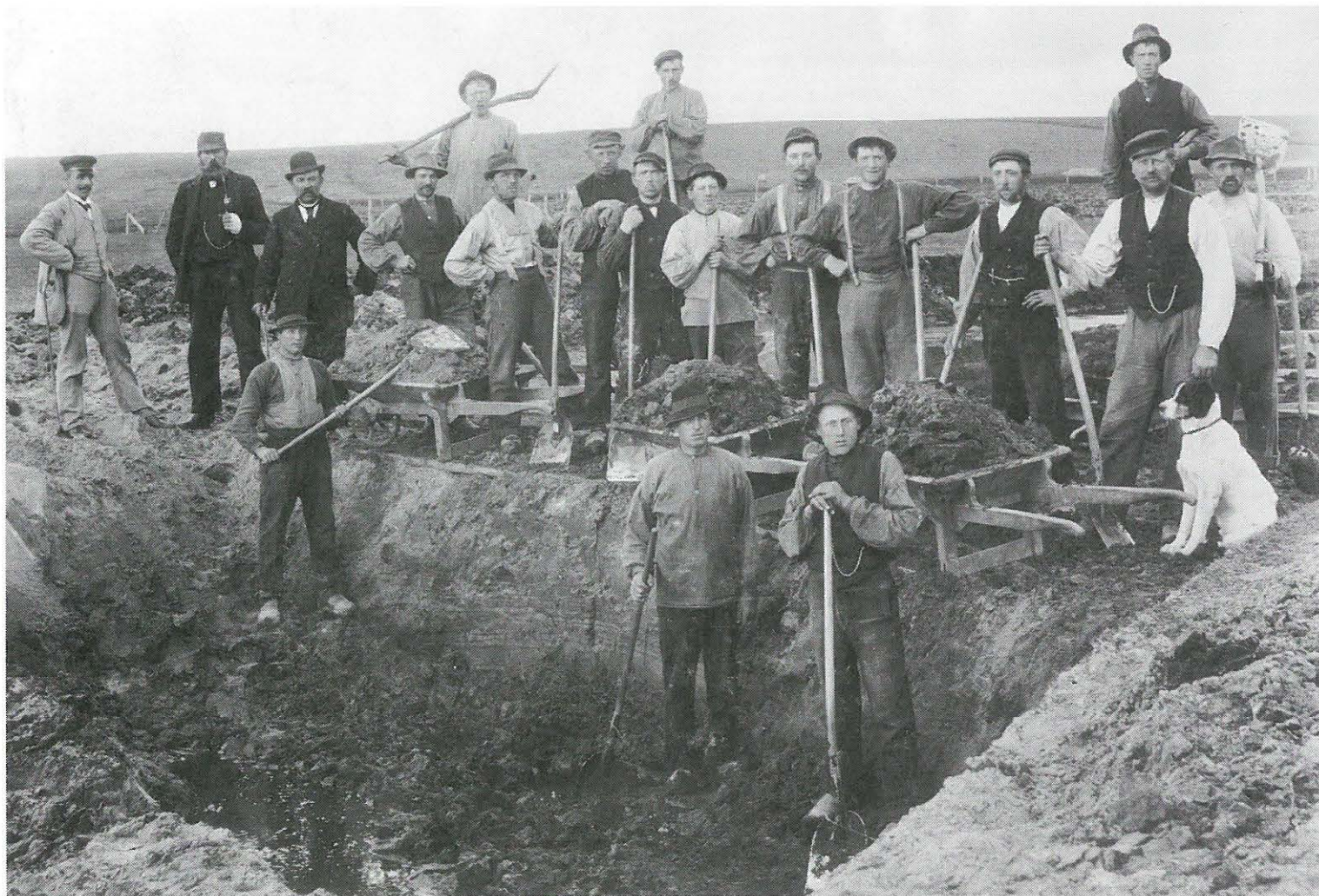
Dette billede er fra Evald Dahlgaard, Hovedgaden 121, Snedsted. Han oplyser, at det er fra kanalgravning i Årup ca. 1925. Nr. 2 fra venstre i bageste række er Kr. Kirk (med lang pibe), nr. 4 fra højre er Kr. Bach Borggaard, nr. 5 Karl Thinggaard. Bagest i højre side står højere oppe end de andre David Borggaard. Evald Dahlgaard er meget interesseret i at få identificeret flere af personerne.
