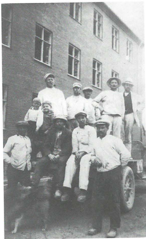
I 1926 fik »Madsen-Jylland« opført et hus i »Jyllands Gård«, Kongensgade nr. 1. Under byggeriet blev dette billede taget af håndværkere på ladet af Madsens lastbil. Forreste række fra venstre: Tømrer Johannes Møller, murerarbejdsmand Chr. Jensen, murer Andersen, en ukendt. I midten to drenge, som fulgte byggeriet nøje: Christian Hald (søn af restauratør Alfred Hald og barnebarn af »Madsen-Jylland«) og Wolf Møller (søn af tømrer Johannes Møller). I bageste række: Murer Månsson, murer Nørskov, murer J. K. Andersen, murer L. P. Larsen og tømrer Chr. Knudsen.
