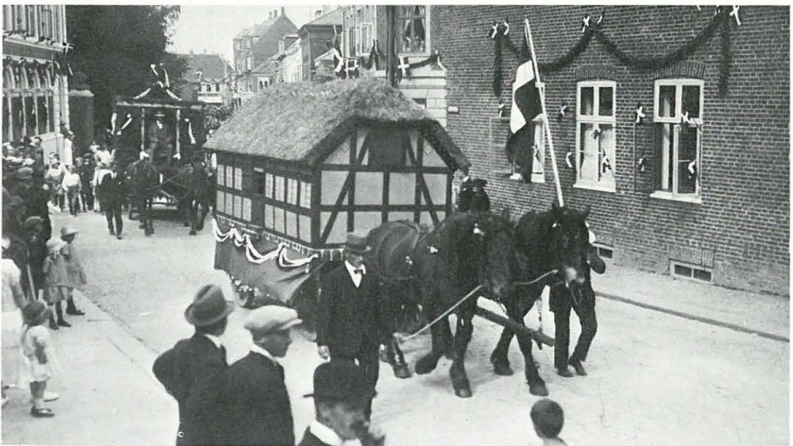
Et stråtekt hus var en af seværdighederne ved Thisteds 400 års købstadsjubilæum i 1924. Billedet er taget i Jernbanegade med præstegården til højre. Vognen med huset er fra Thisted Dampmølle, kusken Søren P. Nielsen. Huset blev efter festen opstillet i haven hos hjælpearbejder P. Skallerup i Thisted Landsogn.
