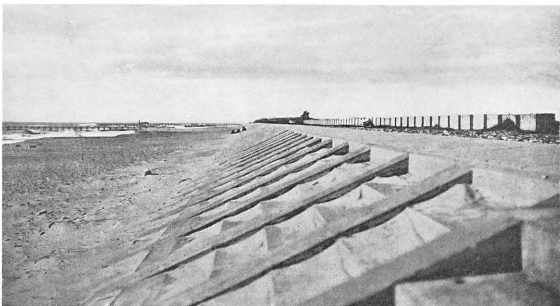
I årene 1926 og 1927 blev der på en strækning af 800 meter fra Agger by ud for Flade sø bygget et trappediget af jernbeton efter hollandsk mønster til sikring af kysten, og 1933 forlængedes trappediget med yderligere 800 meter. Det var et ret stort ingeniørarbejde, der kostede ca. en halv mill. kr. Men allerede i efteråret 1936 blev det hele ødelagt ved, at havet under storm og højvande skyllede ind over diget og underminerede det.
