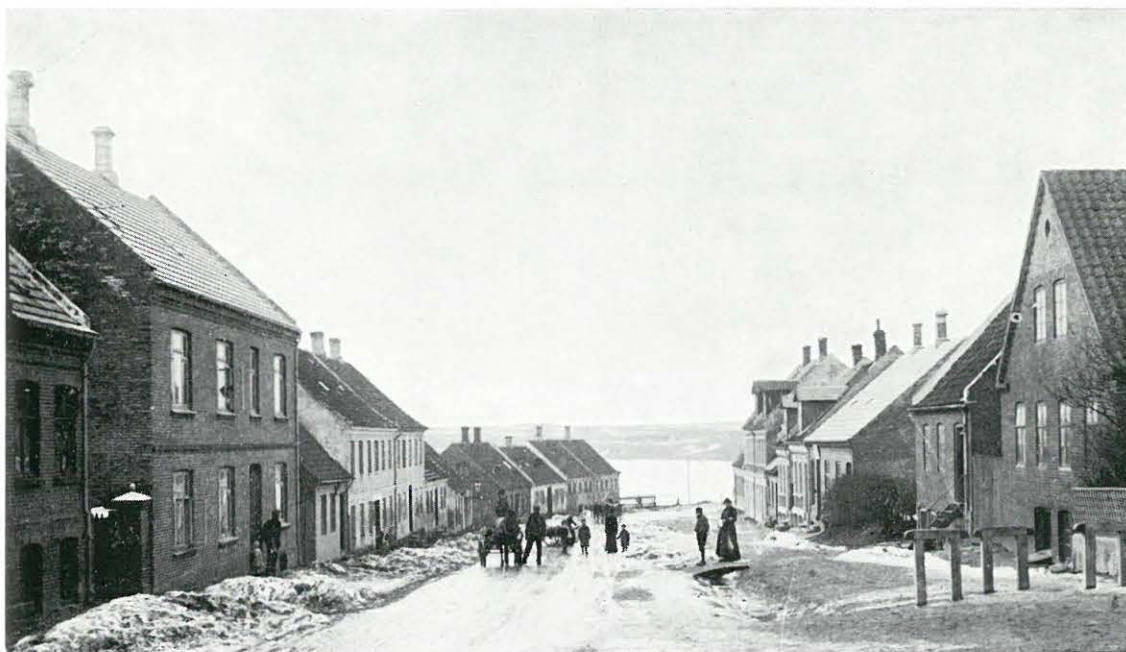
Dragsbækvej i Thisted ca. 1910, en grusvej med åbne rendestene. Drengen til højre er senere malerem. Carl Christoffersen, der står sammen med sin søster Margrete. Ved vognen står mælkeforhdl. vognmand P. Poulsen og ved trækkevognen Carl Stærup.
