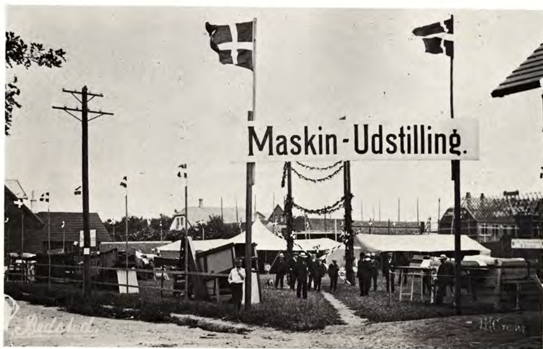
Under opførelse i baggrunden: THs maskinbygning og mejeriet (med spær).
