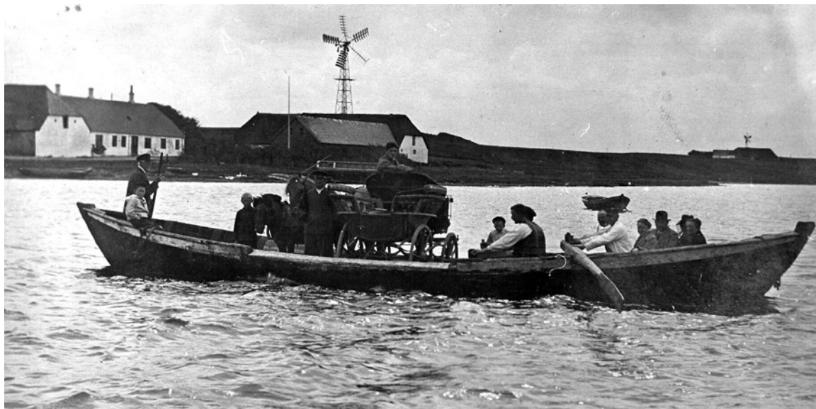
Færgen ved Næssund ca. 1910. Det gamle overfartssted blev betjent af en rofærge. Den blev motoriseret i 1938. Ruten med den sidste træfærge blev nedlagt i 2015. Foto: Lokalthistorisk Arkiv for Thisted Kommune.
