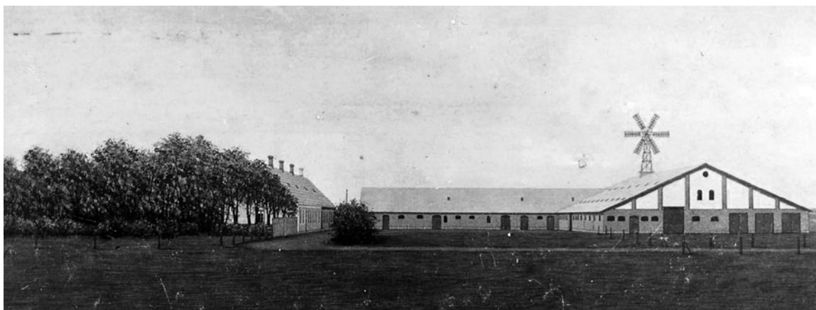
Gårdmaleri af Gadegaard set fra øst med den nye mølle. Gården blev i 1904 blev forsynet med en vindmølle med klapsejlsmotor, som hver dag pumpede 25.000 liter vand op i gårdens vandbeholder, der leverede rindende indendørs vand. Karen Marie og Niels Søndergaard overtog Gadegaard i 1962.
