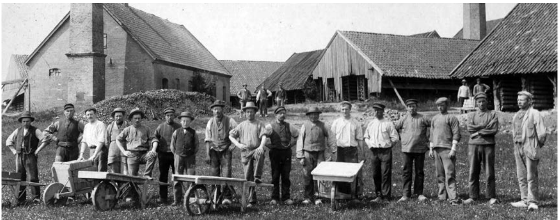
Arbejdsmænd på Landlyst Teglværk, Thisted. Ca. 1900.
