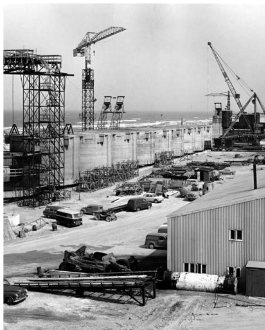
Hanstholm Havn under bygning. Betonstøbte sænkekasser. Ca. 1963.
