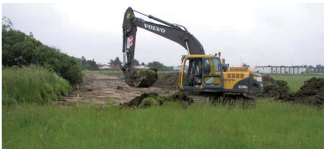
Forste spadestik til diget ved Vildsund. Foto: Henrik Schjødt Kristensen.
