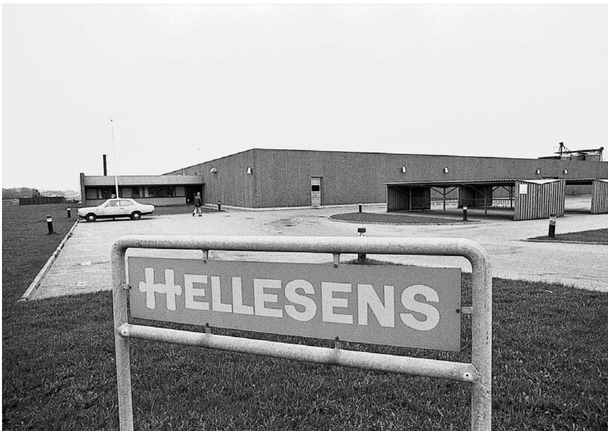
Til Hellekens fabrik opførte Thisted Kommune i vinteren 1971/72 en ny industribygning, placeret i det nyudlagte industriområde ved en vej, der naturligvis – inspireret af Hellekens logo – blev døbt Tigervej. (Lokalhistorisk Arkiv).
