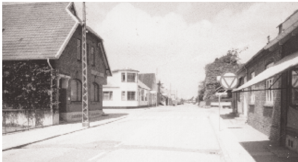
Det i mange henseender centrale punkt korsvejen med malermester Madsens bankbygning til venstre og tømrer P. C. Christensens forretning overfor. Dyr lægeboligen med telefoncentralen lidt skjult bag stoptavlen.
