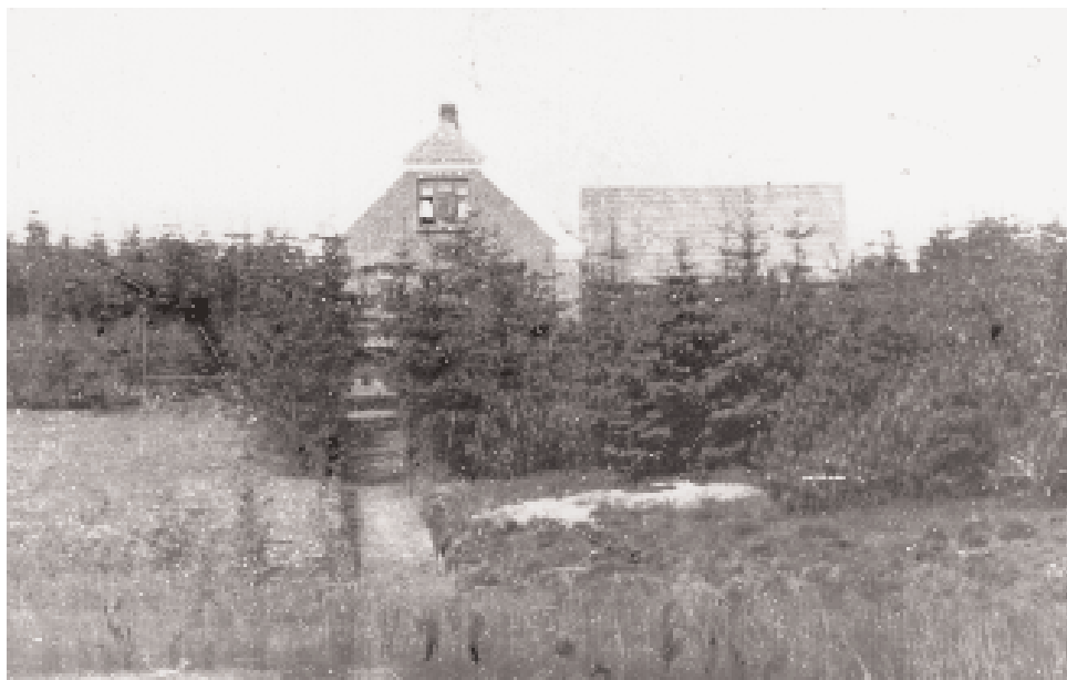
Billedet herover er fra ca. 1925 og viser den af M. P. Boddum i 1923 for egen regning opførte bolig for plantagens opsynsmand. Ejendommen overgik først i trediverne til staten og er flere gange tilbygget og ændret.
